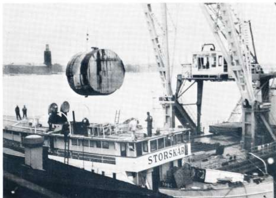
Ångaren STORSKÄR:s gamla ångpanna lyfts upp genom matsalongen av pontonkranen LODBROK. Foto Olle Malmqvist 6 november 1975.
